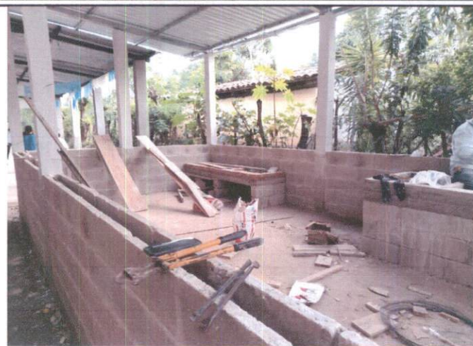
Foto 2: Avance en mejoramiento de la estructura del pórtico de la cocina, instalación del polletón y los lavaderos.
