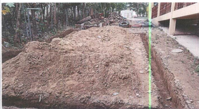
Foto1: Inicio del zanjeado para el mejoramiento del pórtico de la cocina.
