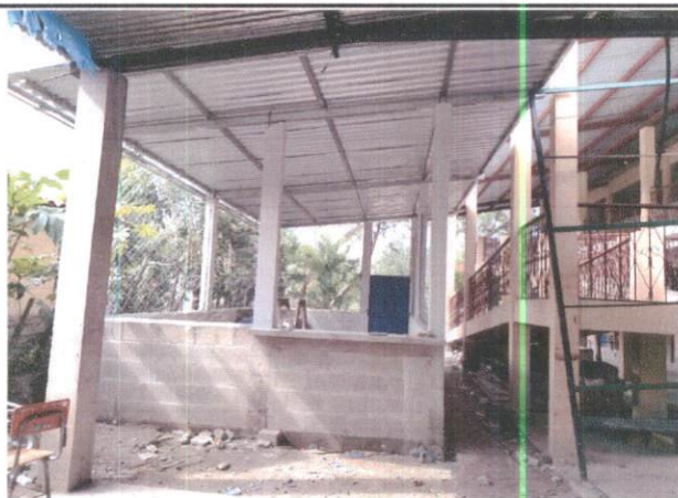
Foto 3: Instalación de la estructura y techado del pórtico de la cocina
